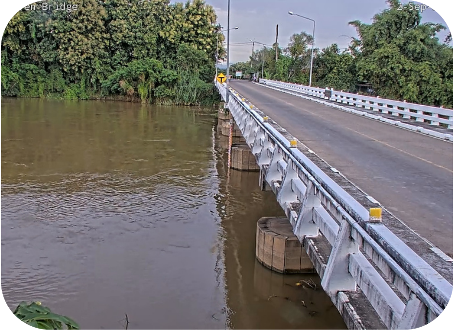
สะพานหลวงพ่อบุญเย็น อ.ป่าซาง จ.ลำพูน
